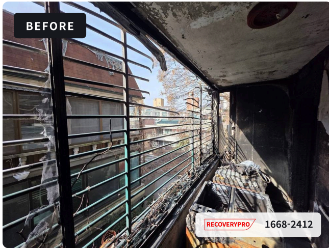
빌라 베란다 화재 — 잔해 반출, 탄화층 제거, 창호 설치 및 도장
