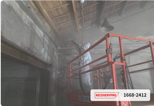
대형 화재 현장 — 고소작업대를 이용한 천장 그을음 제거
